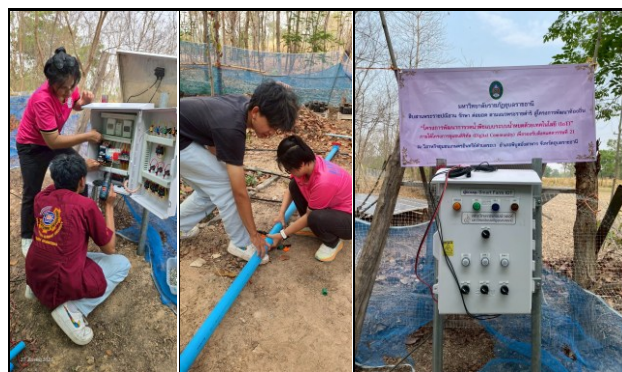
รูปที่ 6. การติดตั้งระบบน้ำหยดด้วยเทคโนโลยีอินเทอร์เน็ตทุกสรรพสิ่ง
